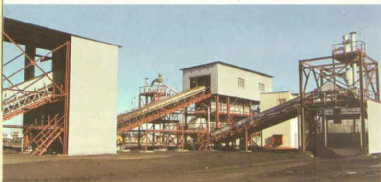
Участок подготовки топлива
